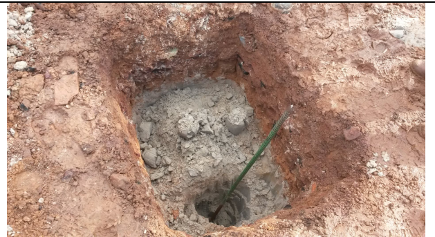
Foto 10: Escavação concluída (1,30m)
