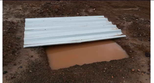
Foto 06: Vale com água da chuva.
