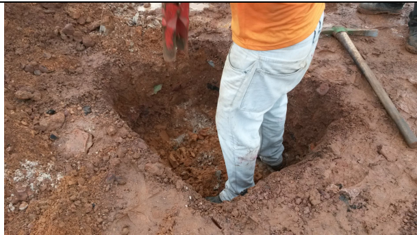
Foto 09: Escavação em andamento
