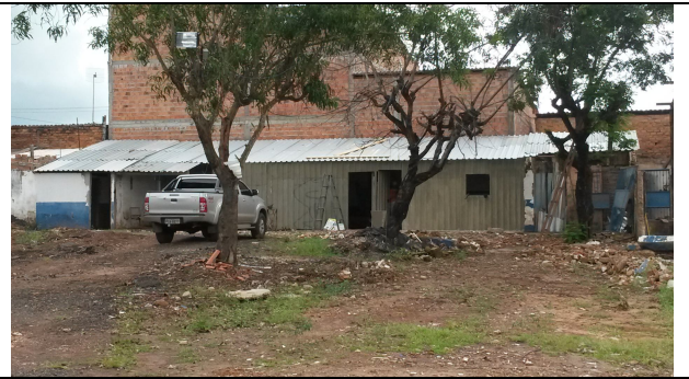
Foto 02: Barracão da obra
