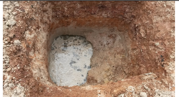
Foto 12: Escavação no dia seguinte
