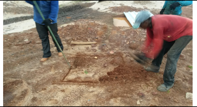
Foto 08: Início da escavação da vala
