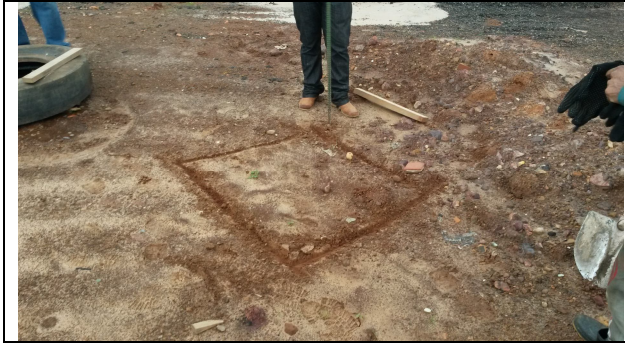
Foto 07: Demarcação da área a ser escavada
