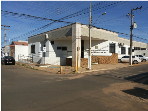
fachada do prédio
