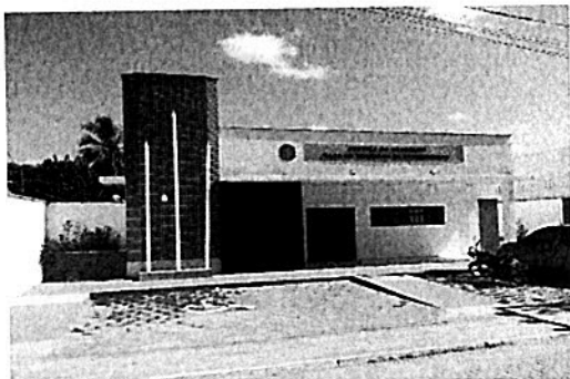
Fachada do Fórum
