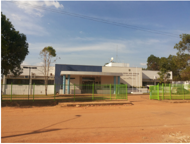
Fachada do Fórum
