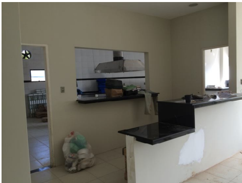
Obras para instalação de restaurante no Foro Astolfo Serra
