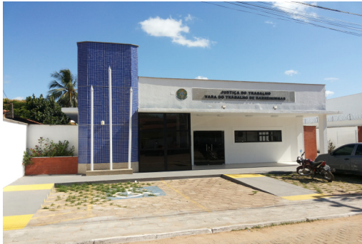
Fachada do Fórum
